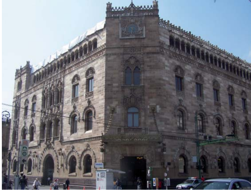
1. Edificio Central de Correos. Arquitecto Adamo Boari, 1903-1910 (Fotografía de Guillermo Boils, 25 de marzo de 2004).
